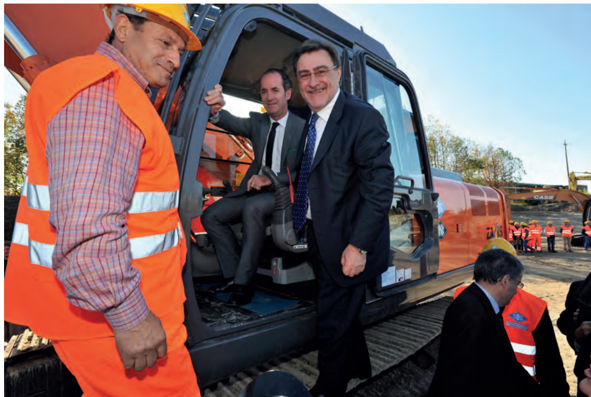
Luca Zaia e Renato Chisso all'inaugurazione del cantiere Spv
